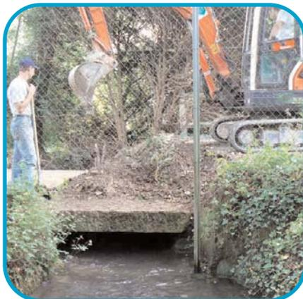
A ce jour, après coffrage, une dalle a été coulée sur 20 cm d'épaisseur. Un muret est prévu à chaque extrémité pour tenir les accotements. La chaussée sera reconstituée sur 2,50 m de largeur avec des accotements stabilisés.
