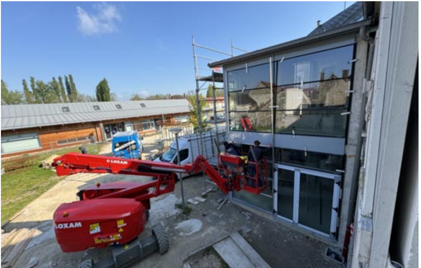
Les travaux de rénovation avancent... future entrée de l'accueil Mairie.
