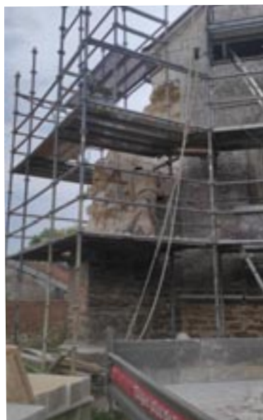
Reprise des contreforts de l'église
