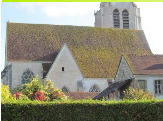
Toiture église Saint Mammès Photo ©Thierry Leynet, Architecte du patrimoine
